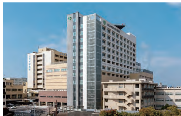
附属病院外観写真
