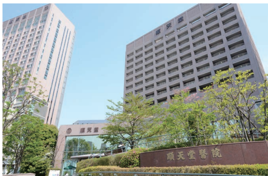
順天堂医院外観
