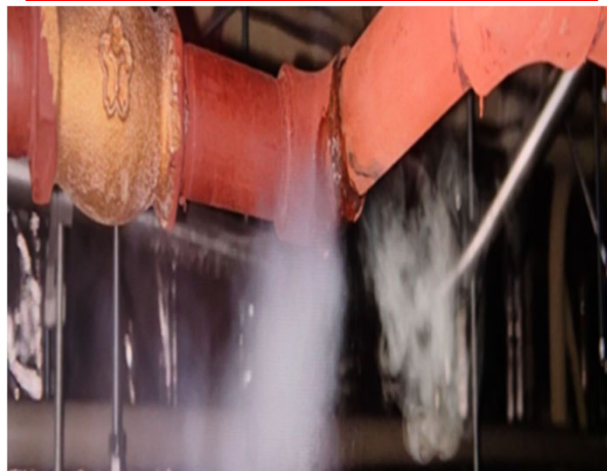
G-02 蒸気管の破損
