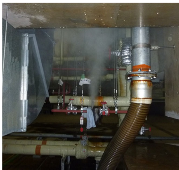
G-02 蒸気管の破損
