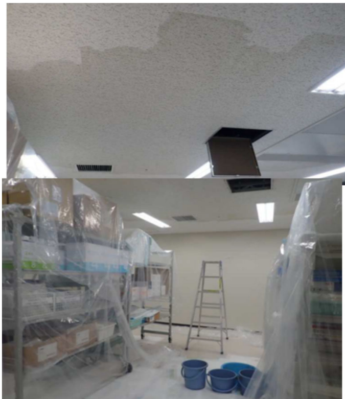
T-06 病棟MEセンター漏水による天井落下
