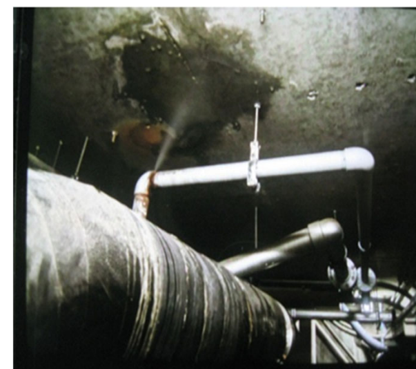
K-06 ボイラー棟配管蒸気漏れ
