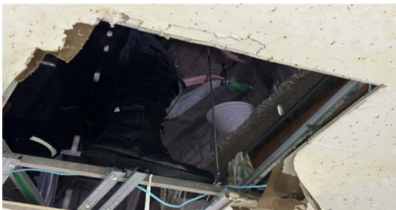
T-06 病棟MEセンター漏水による天井落下
