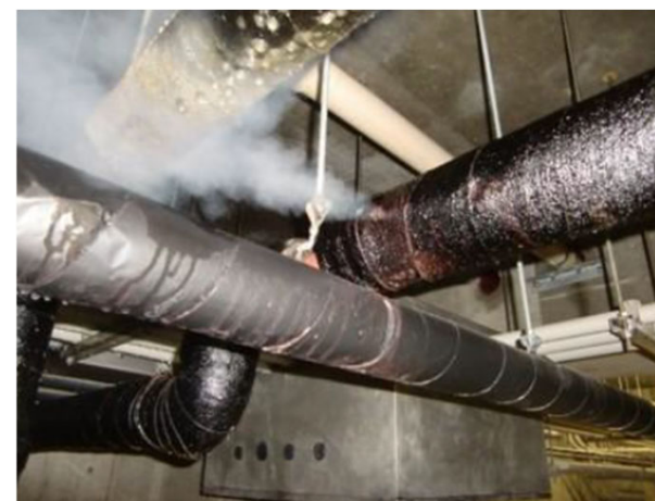
K-06 ボイラー棟配管蒸気漏れ
